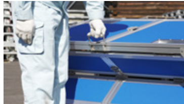
2 長手面パネルを引き上げます。
